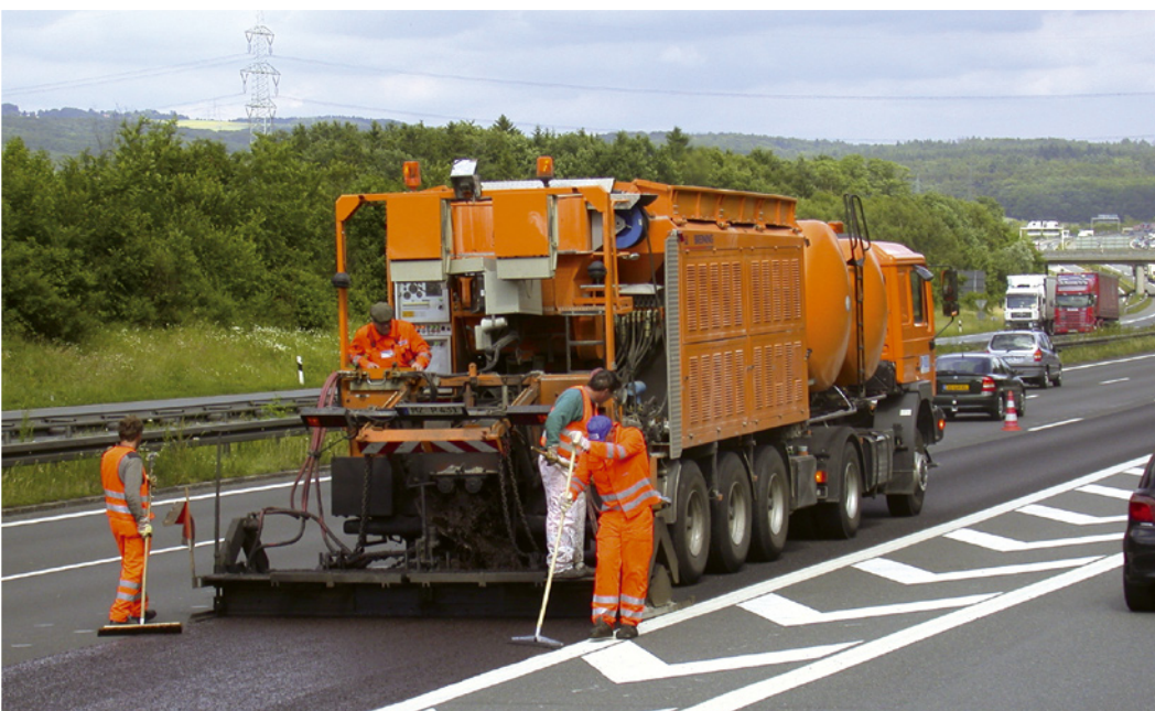
Einbau eines DSK-Belags
