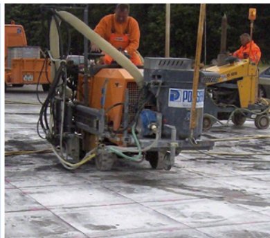
Betonplatten teilen und erschütterungsfrei aufnehmen
