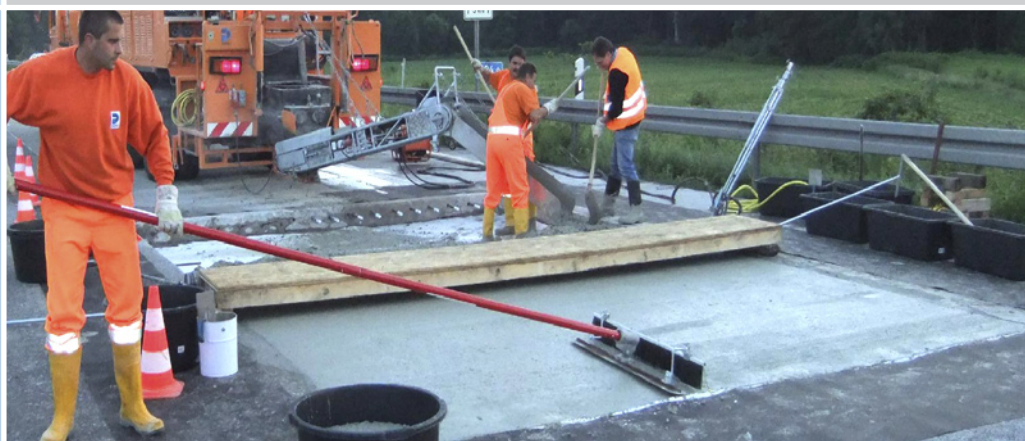
Schnellbeton vor Ort aufbereiten und neue Platte herstellen
