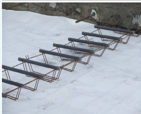
Dübel und Anker einbauen
